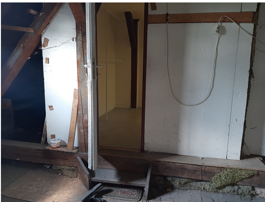
nápojení konstrukce půdní vestavby na krov
